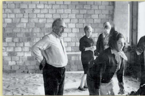
Міністр торгівлі України Г. А. Сахновський на суботнику з будівництва КТЕІ
